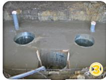
約3mほどの穴を掘り、シリンダー・ポンプユニット、据付用パイプを設置します。
